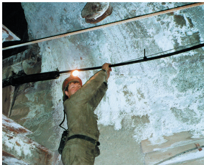
Монтаж подземной телекоммуникационной сети комплекса «Талнах»
